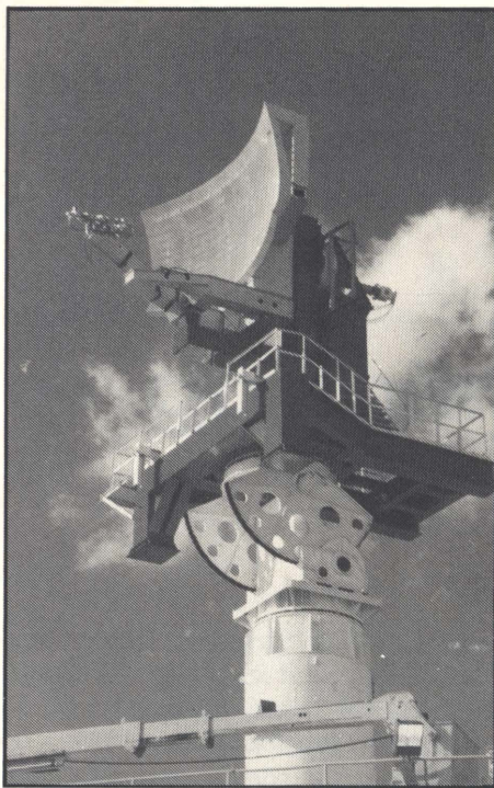
Her ses den nyeste generation af lufthavns-radarer af typen ASR-9 (Airport Surveillance Radar), der i de næste par år opstilles i større amerikanske lufthavne.
